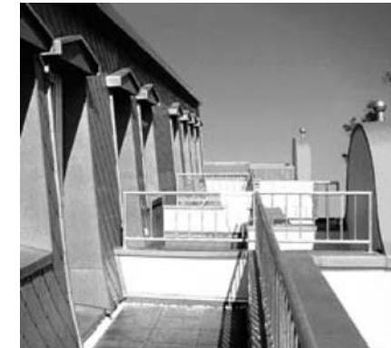
Фото 14.2: Использование RHEINZINK® - строительных профилей для окрытия парапетов
