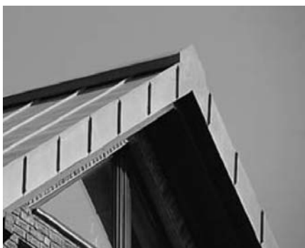
Фото 7.2: Узел соединения конька с ребром, низкий вариант
