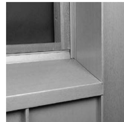
Фото 11: Оконный проём с боковым примыканием к парапету
