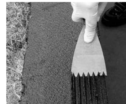
Фото 3.1: Enkolit® наносится гребенчатым шпателем
