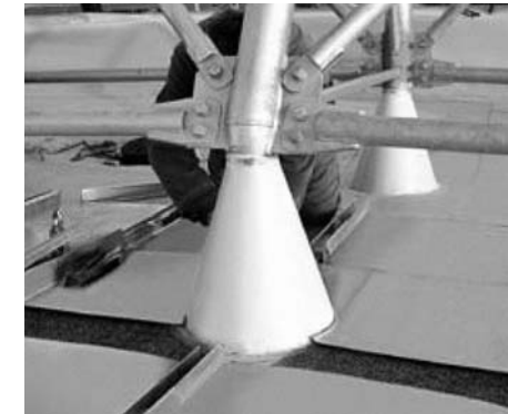
Фото 4: Область кровли с большим количеством проёмов
