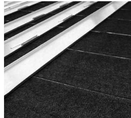
Фото. 5.2: Структурная мембрана с пленкой укладывается на сплошную деревянную обрешётку
